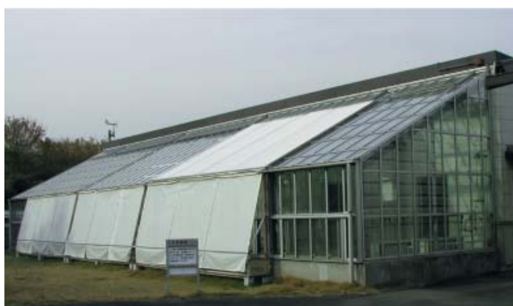
酸化チタンコーティングメッシュ施工後
