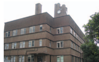
改修前（上）と改修後（下）
