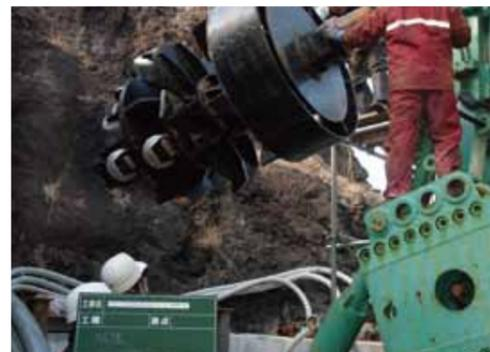
本プロジェクトでは自然環境を損なわずに自然の力を利用するために、新たな掘削技術を考案し、海まで貫通するブローホールを掘削しました。これにより、長寿命・高耐久性を実現しています。事前に行われた流体・構造解析によって、エネルギー変換装置としての性能も確認されました。
