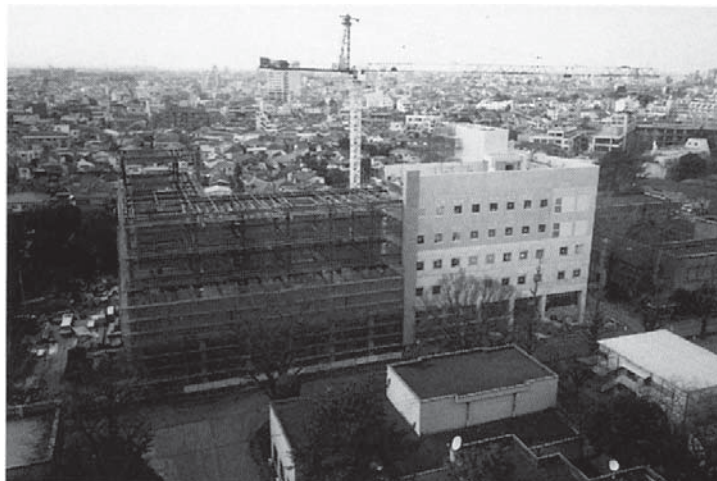
第1期工事中の駒場Ⅱキャンパス
