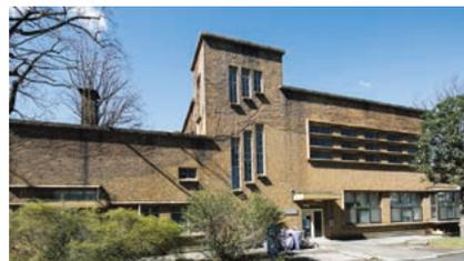
左の縦長の窓は、階段に自然光を取り入れるため段々に配置されている。右の横長の窓はモダニズム。「階段の機能をそのままファサードのデザインに反映させている、機能主義的なデザインです」
