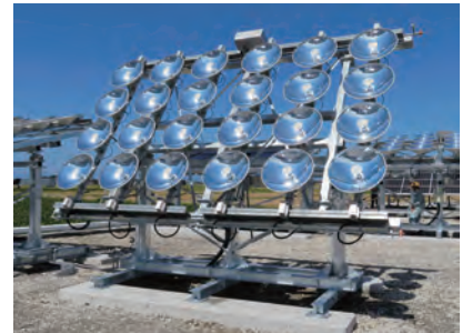
3 ハイブリッドCPV-Tモジュール Hybrid CPV-T module
