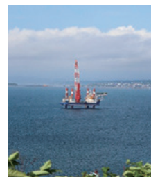
上ノ国の海底地盤調査 (ボーリング調査)の様子
